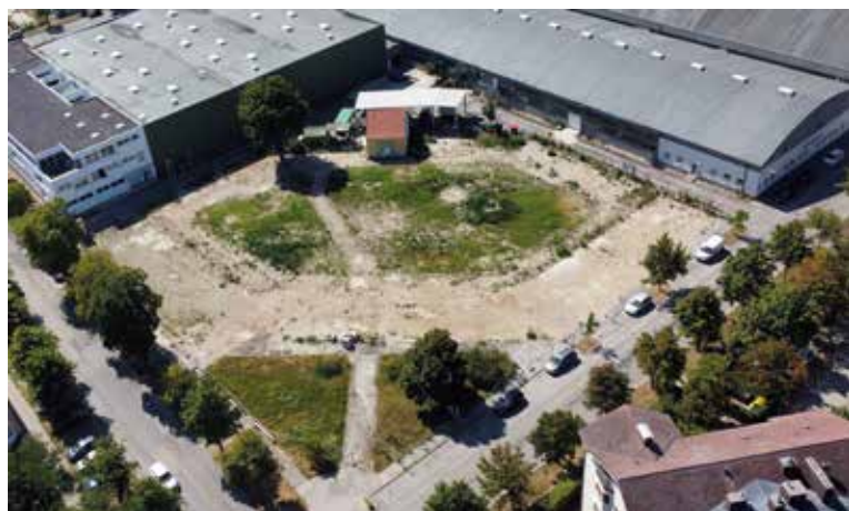
Ab 11. September 2024 wird hier das neue Mietwohnhaus errichtet.
